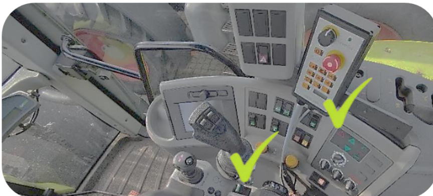
Bedieningspaneel en joystick gemonteerd en geïnstalleerd in de cabine
